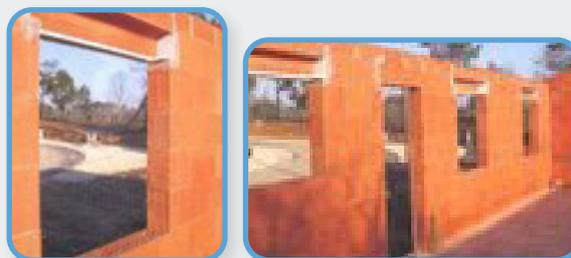
De par sa conception, «BB-COMPACT» assure automatiquement une rigidité à la traverse haute de la fenêtre dans la mesure où «BB-COMPACT» est reliée au linteau.
